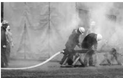
水道管復旧デモンストレーション
