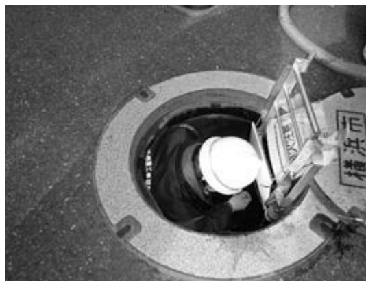
写真3 応急給水資機材保守点検の様子
