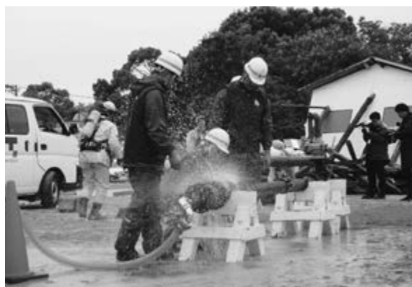
写真① 水道復旧デモンストレーション
