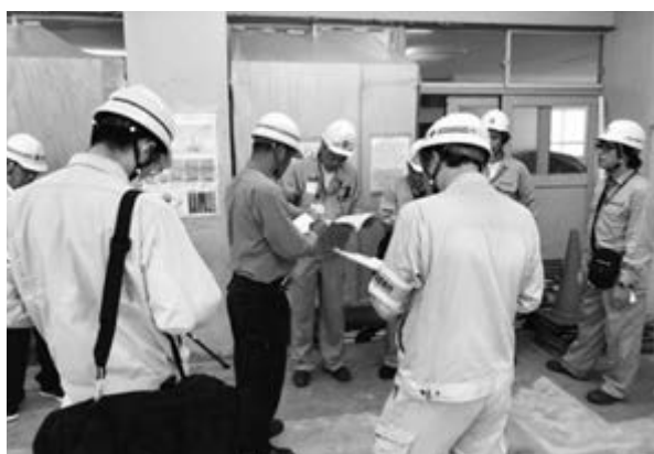
施工体制台帳確認
