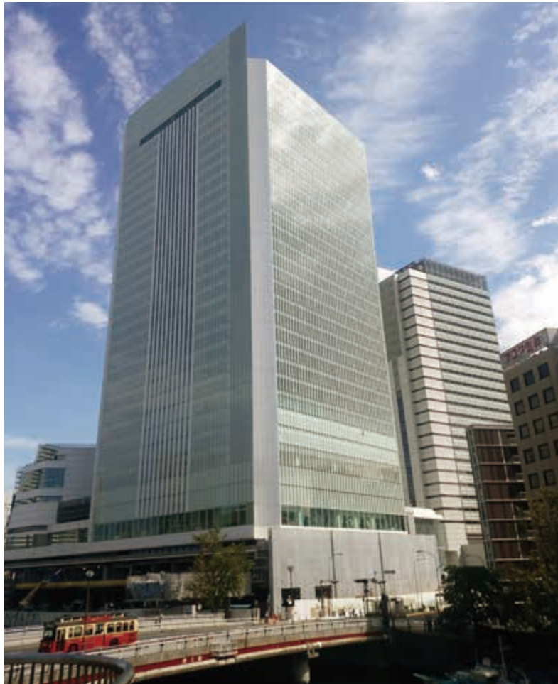
(横浜市新市庁舎 2020年春 竣工予定)
