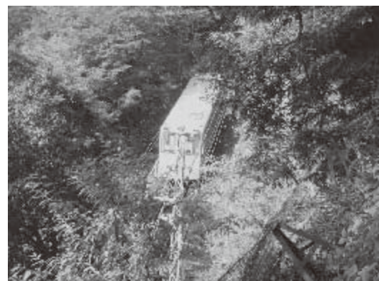
昭和40年開通のケーブルカー
