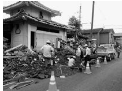
復旧作業の様子 (高和管設株式会社様)
