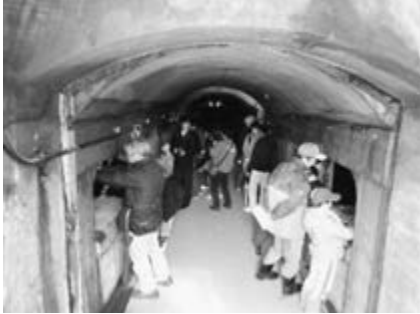
1号配水池の内部
